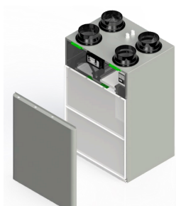
B. Odstraňte přední panel
