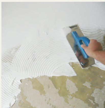
Provádí se na vyrovnaný a penetrovaný podklad, na stěny, stropy i podlahy.
